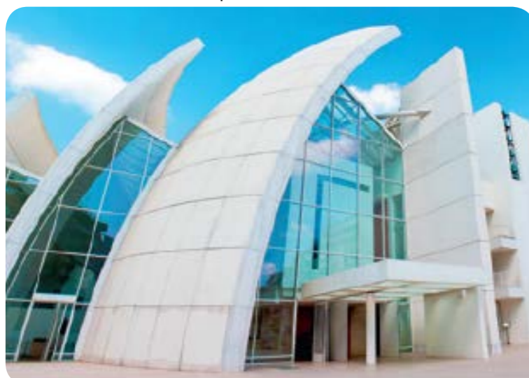
Figura B La copertura della chiesa Dives in Misericordia di Roma è di cemento autopulente.
